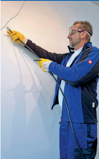
Abdichtung von Deckenfugen
