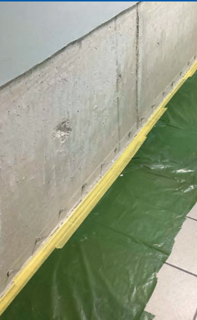
Abdichtung von Anschlussfugen
